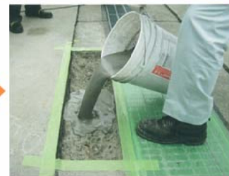
流し込み(セルフレベリングタイプ)
