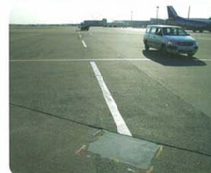
コンクリート舗装欠損部補修
