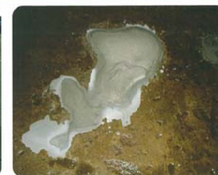
冷凍冷蔵倉庫床面補修
