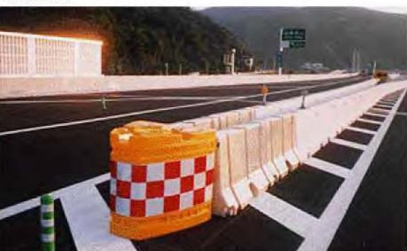
中央分離帯 \*システムカディ(コンクリート充填)との接続例
